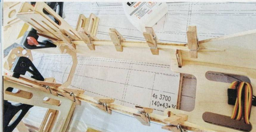
Mit dem Rumpf in Normallage werden weitere Spanten eingesetzt und verklebt.
